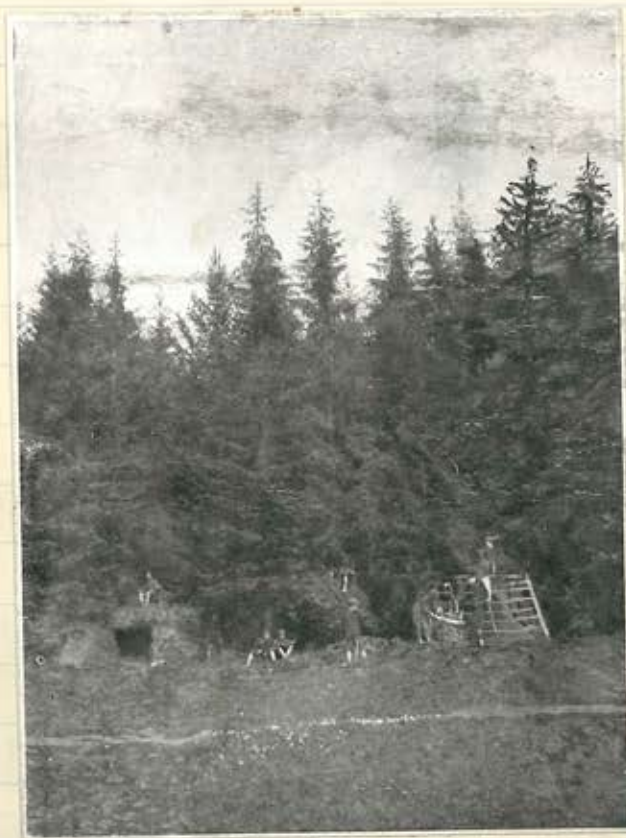
Budowa sztalasów na polanie w Zaradni.
