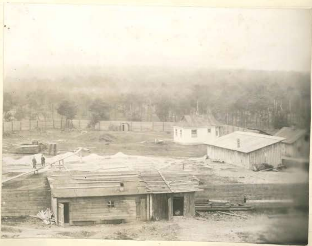
Widok na skład materiałów i budynki administracyjne.
