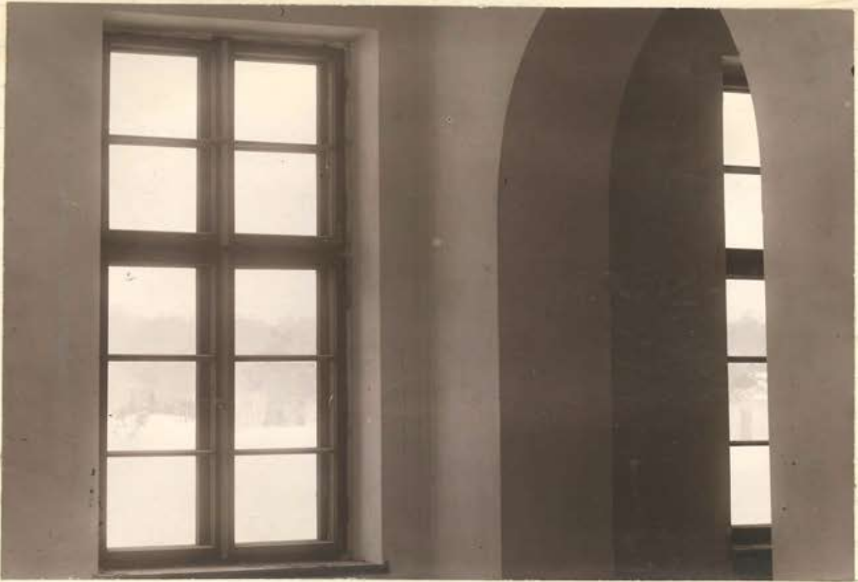
Okna głównego gmachu w styczniu 1929 r.
