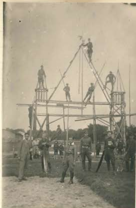
Budowa bramy głównej bojska N. K. S. „Thomasovia”.
